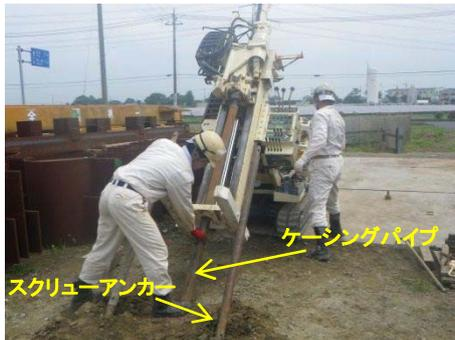
写真-4 ケーシングパイプ設置状況<sup>2)</sup>
