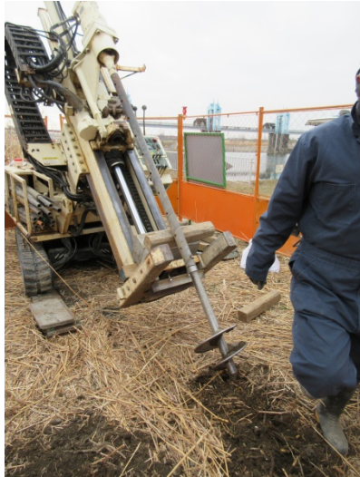
図-3.1 アンカー施工状況
