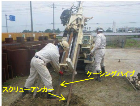
写真-4 ケーシングパイプ設置状況 2)
